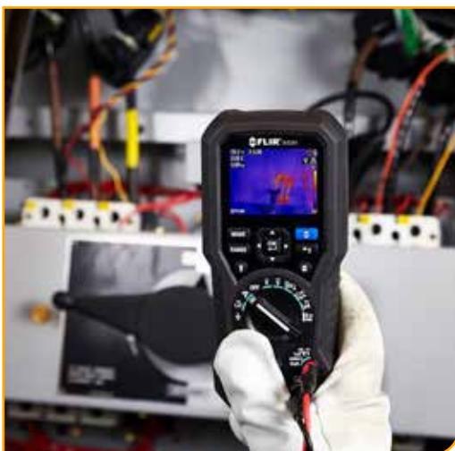
Escaneo térmico de un cuadro eléctrico.
