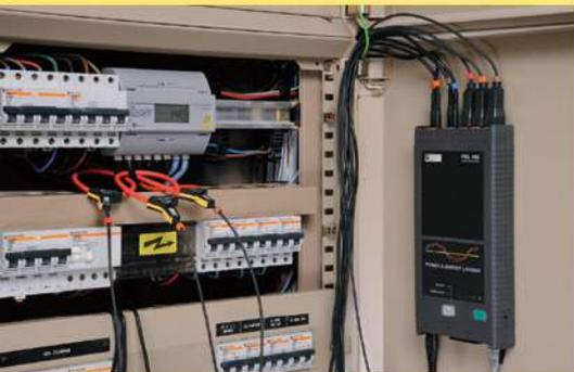
Se puede detectar instantáneamente todo rebasamiento de umbral de potencia suscrita. Con el software de generación y edición automática de informes, balances, gráficos o síntesis DataView®, el usuario podrá intervenir rápidamente sobre la causa de este consumo excesivo, que ocasionará una factura más elevada. En efecto, cualquier rebasamiento de umbral respecto a la potencia suscrita dará lugar a una factura con un importe más alto.
